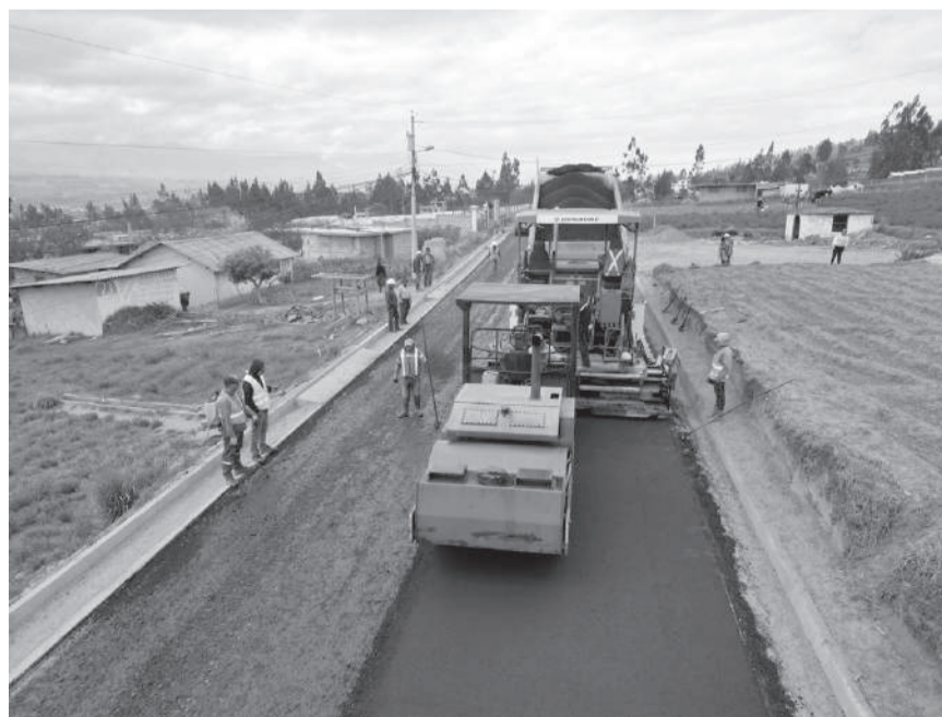
Asfaltado tiene 85% de avance.
