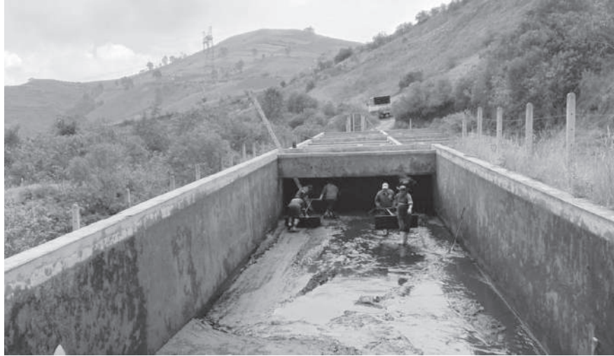
■ Obreros de la EPAPAP en la limpieza del tanque de sedimentación en Cuturiví.
