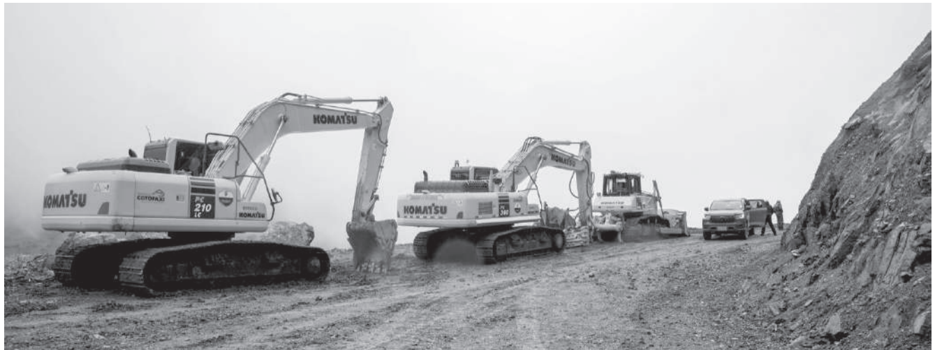
■ Nuevamente quedaría paralizada la maquinaria y avance de la obra vial.
