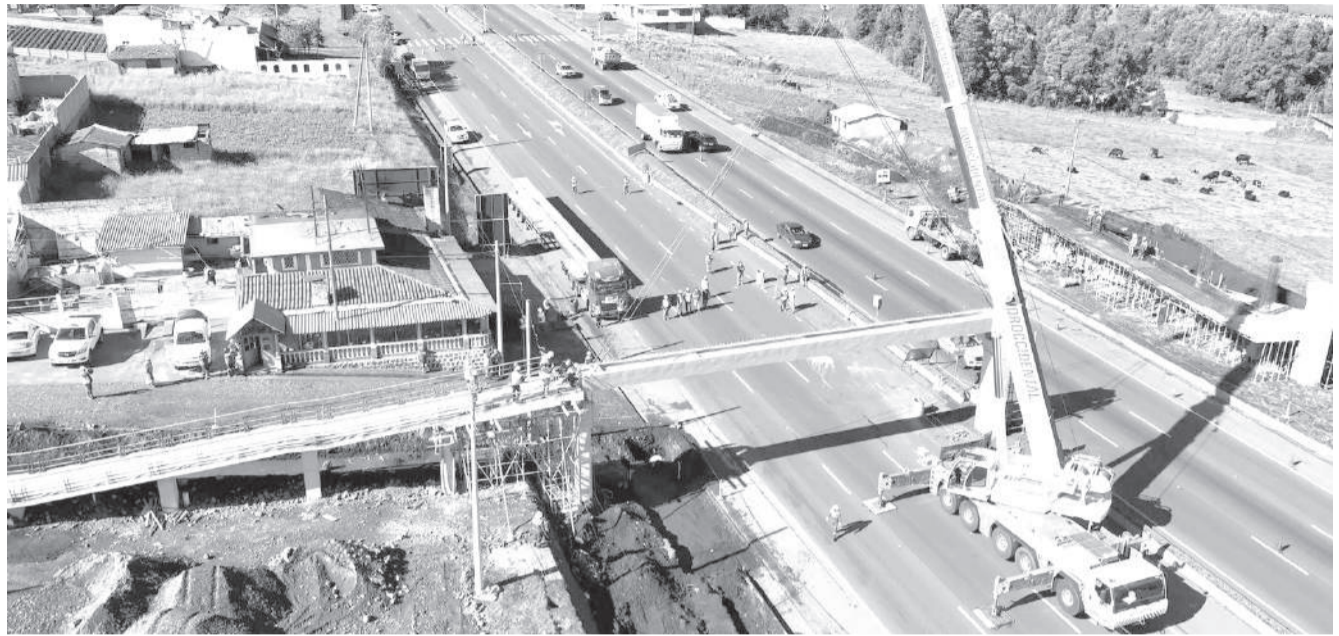
■ Construcción de paso peatonal elevando en Romerillos.
