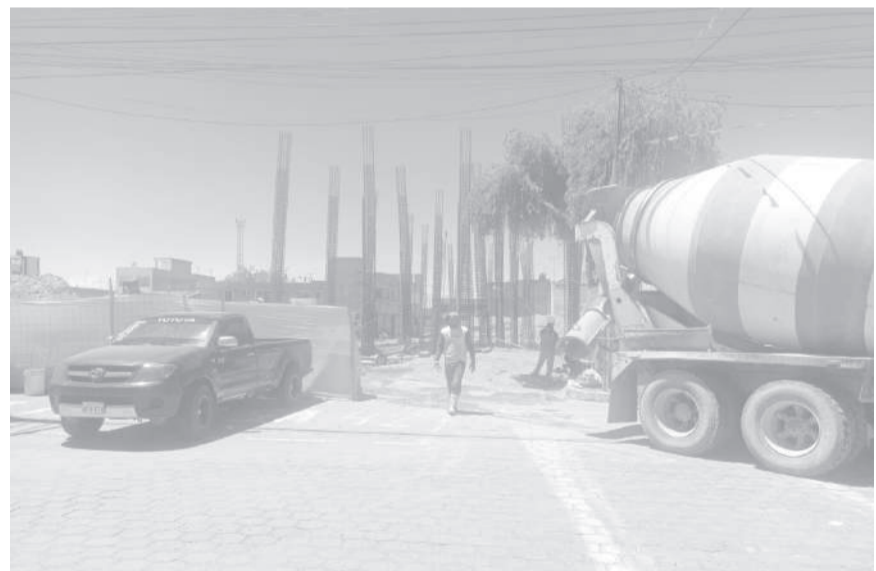
Trabajos en la obra.
