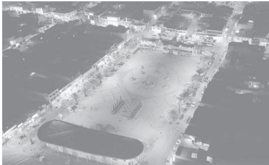
■ Vista aérea de la plaza cultural 'Sucre' de la ciudad de Pujilí.
