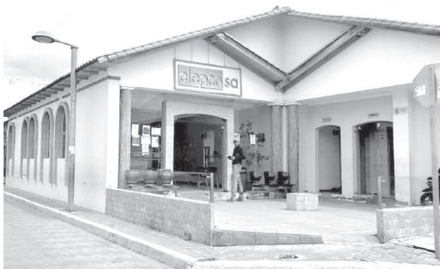
■ Vista de la agencia de recaudación de la ELEPCO en la ciudad de Pujilí.
