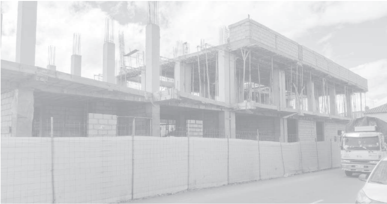
■ Avance de la obra.
