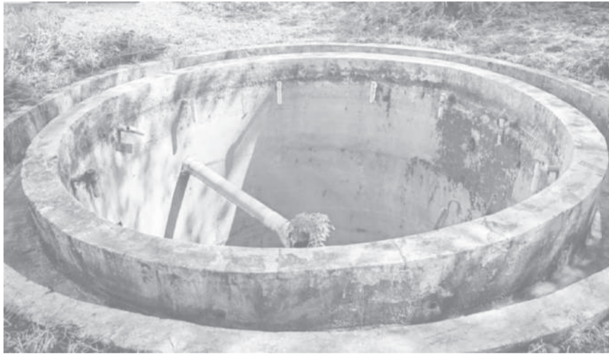
Realizan la limpieza de las plantas residuales en Pujilí.
