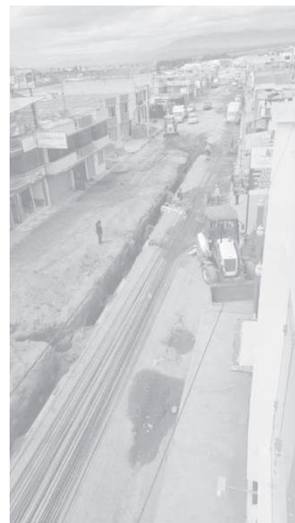
■ Trabajos de reemplazo del sistema de alcantarillado en la vía Bellavista – Puente de Aláquez.
