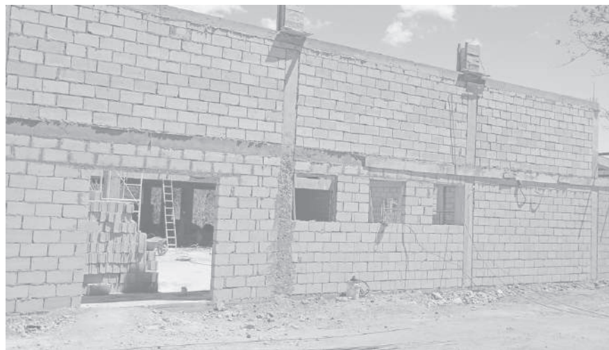
■ Construcción de la nueva planta de Perla Andina, de Sigchos.
