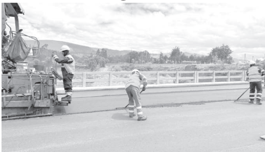
■ Trabajos en la vía E-35 se ejecutaron de forma planificada.
