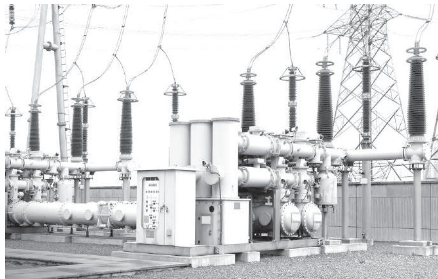
Subestación será construida en Tanicuchí.
