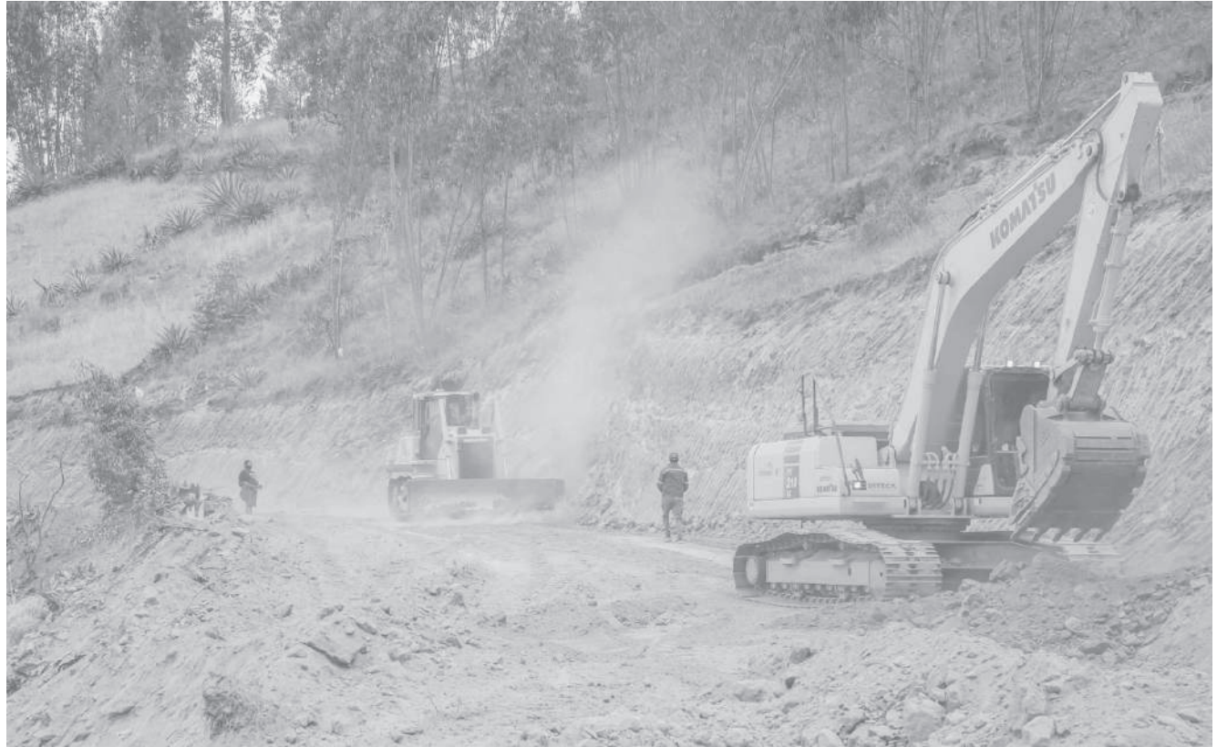
■ Maquinaria de la prefectura de Cotopaxi avanza con la ampliación de la vía al noroccidente de Pujilí.
