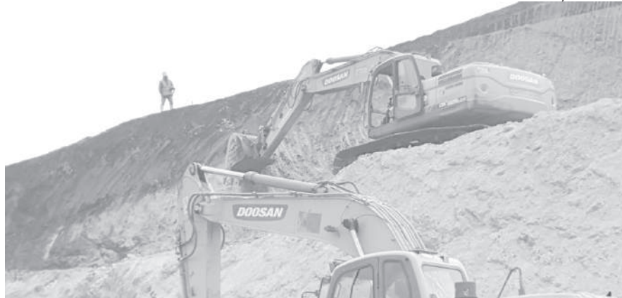
El contratista continúa con los trabajos para la construcción de la variante de Saraugsha.
